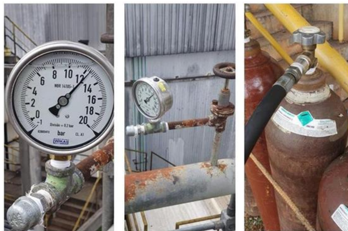
Figura 9: Teste de estanqueidade
