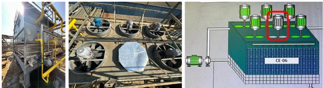
Figura 12: Retrofit componentes condensador evaporativo
