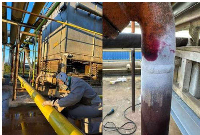
Figura 11: Instalação das tubulações e teste por líquido penetrante nas soldas
