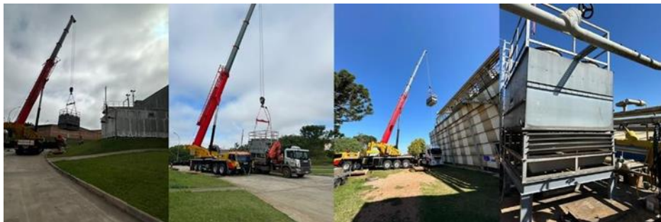
Figura 10: Etapas movimentação do condensador evaporativo
