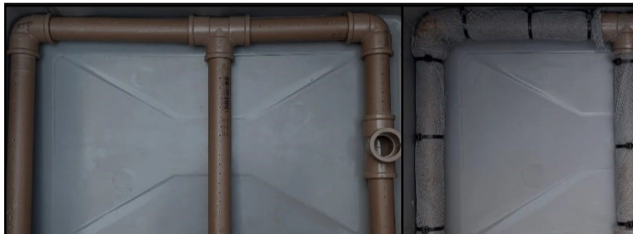
Figura 10 – (A) Hidráulica semipronta ;(B) Acabamento final
