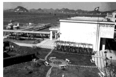
Figura 6: Lateral da Estação de Hidros.
