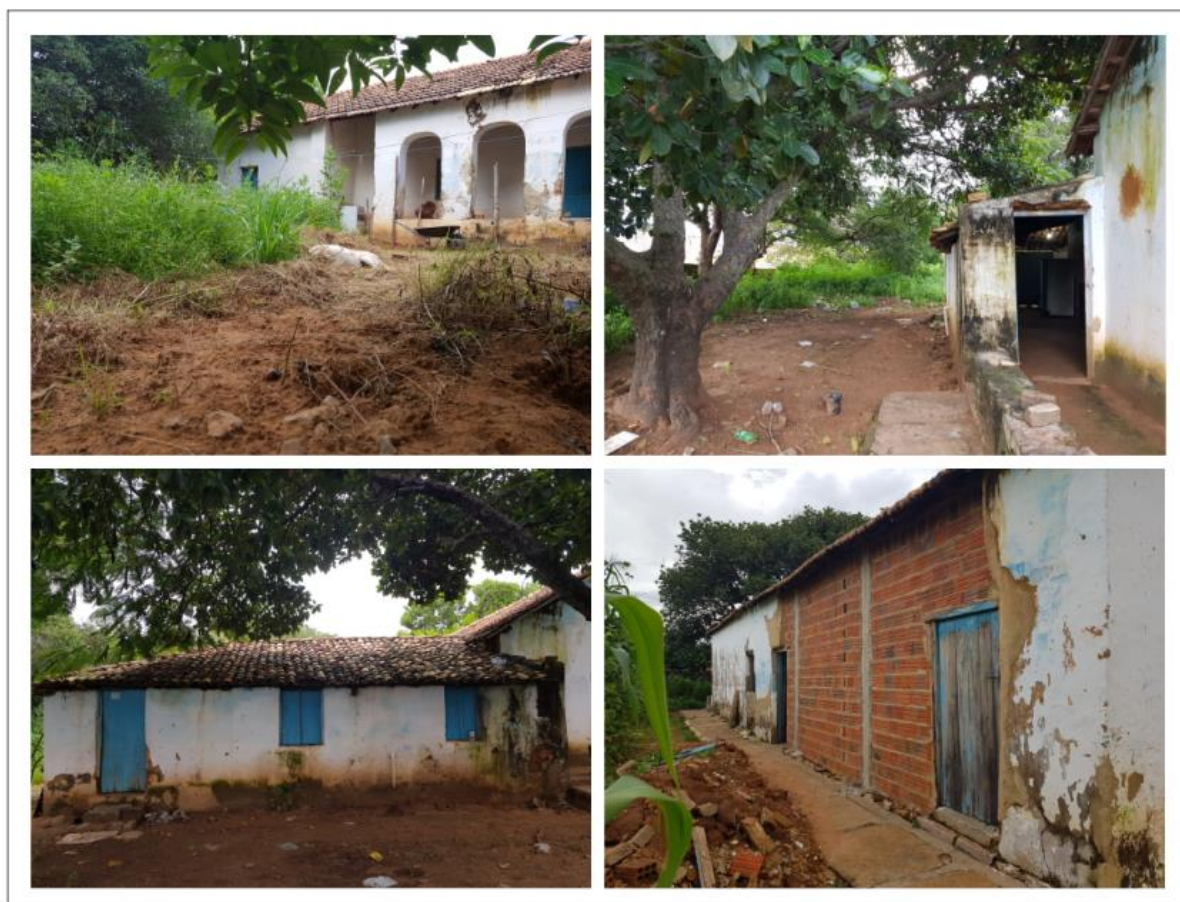
Figura 04: Imagens da parte externa do lote com (a) fachada lateral esquerda com varanda arqueada; (b) acesso para a parte posterior do lote pela cozinha; (c) parte posterior do lote com esquadrias da cozinha; e (d) fachada lateral direita com porção com interferência construtiva.
