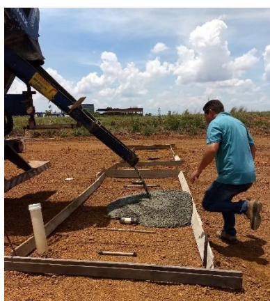
Figuras 5 – Concretagem do pavimento Fonte: Autor (2021)
