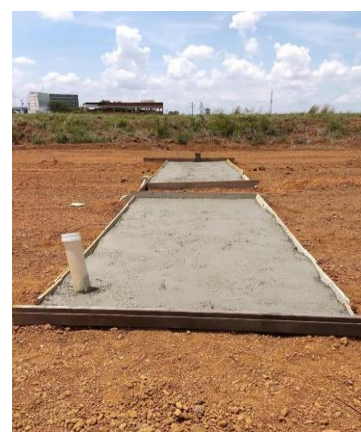
Figuras 6 – Pavimento finalizado Fonte: Autor (2021)
