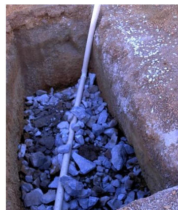
Figuras 3 – Enrocamento Fonte: Autor (2021)
