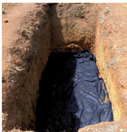
Figuras 1 – Camada de Geotêxtil Fonte: Autor (2021)
