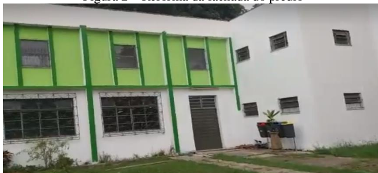
Figura 2 – Reforma da fachada do prédio
