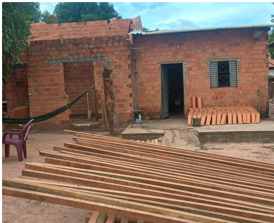
Figura 3: Casa do Sr. Deusiran, construída por mutirão na ocupação Presidente Lula
