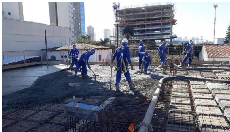
Foto 5: Execução da Concretagem da Laje Nervurada
