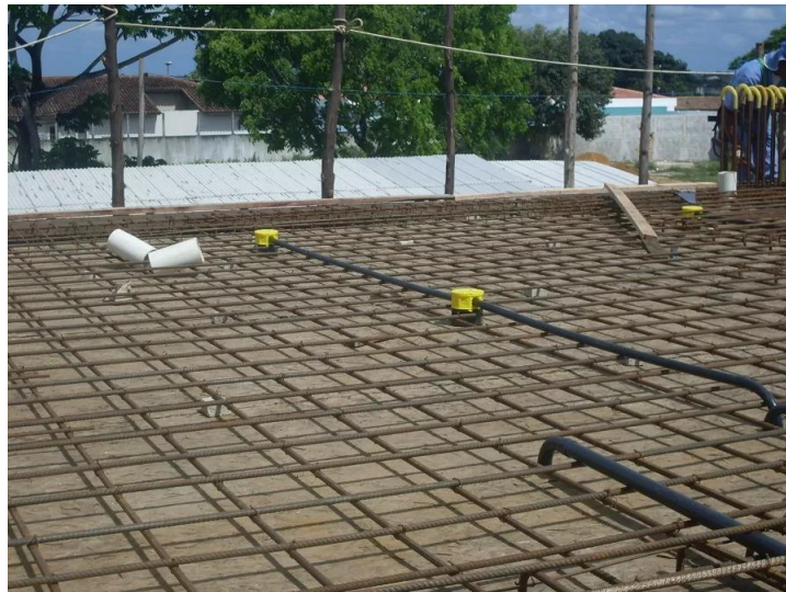
Foto 8: Execução de Armadura de Aço em Laje Maciça
