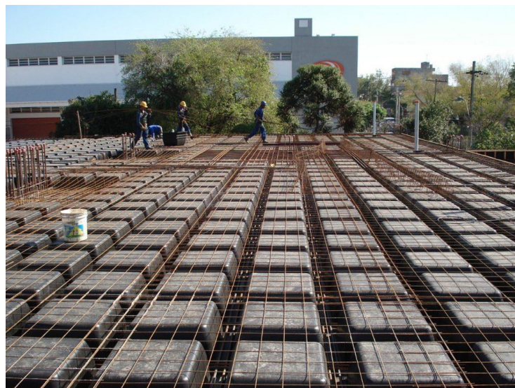
Foto 4: Execução da Armadura de Aço para Laje Nervurada
