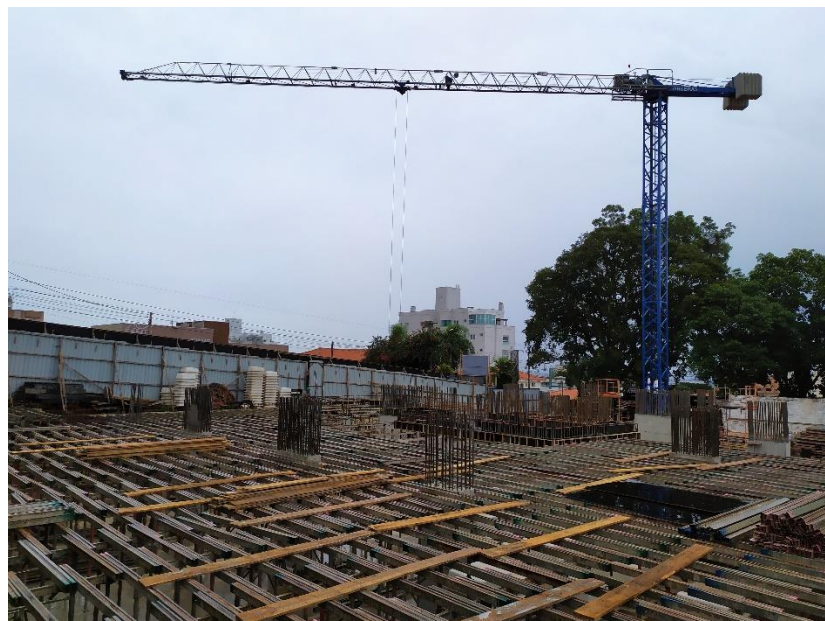
Foto 3: Execução de Forma para Laje Nervurada
