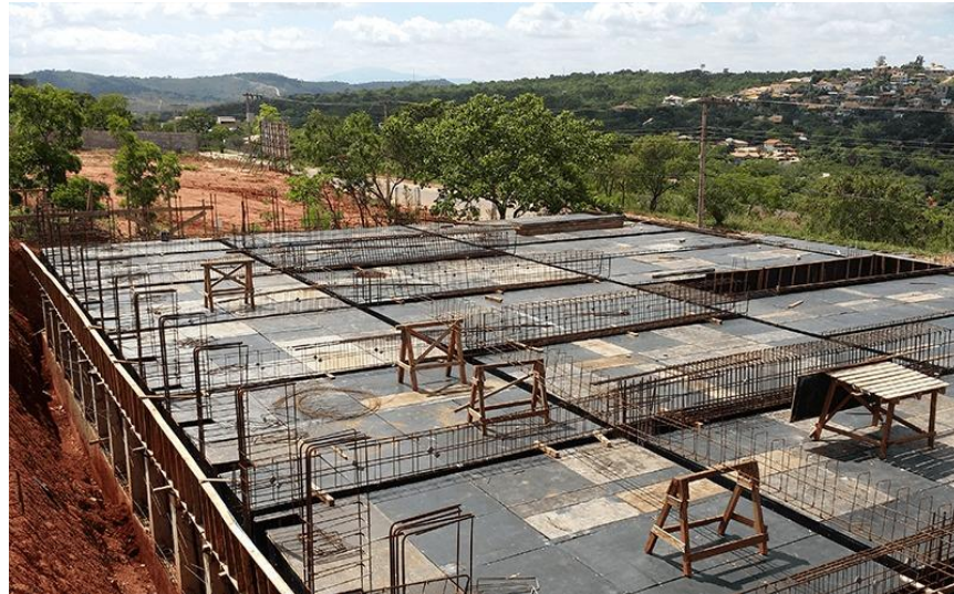
Foto 7: Execução de Forma para Laje Maciça
