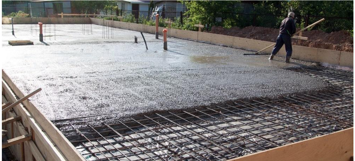
Foto 9: Execução de Concretagem da Laje Nervurada
