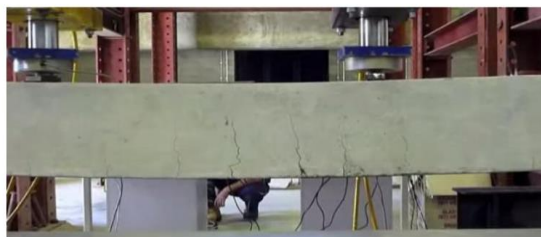
Figura 4 – Fissuras causadas pela flexão em viga.
