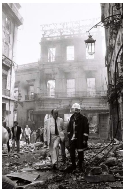
Figura 1: Vista da Rua Garrett e do edifício Armazéns do Chiado após o incêndio de 1988. Fonte: Avelar, 2020.
