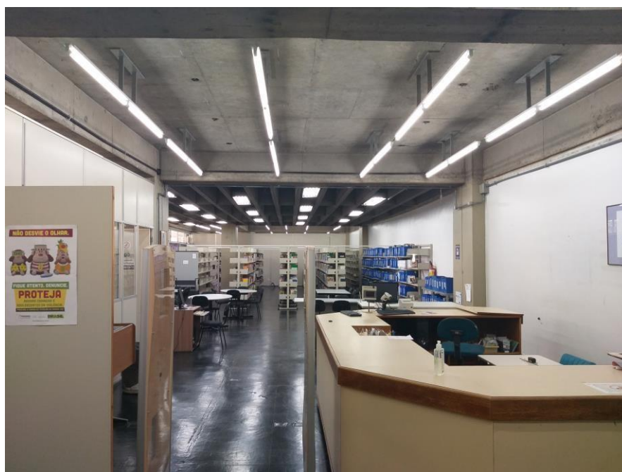
Imagem 3: Salão da Biblioteca Comunitária da UERJ após retirada do forro e adequação da iluminação
