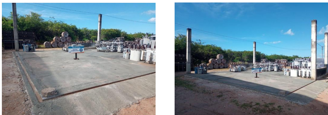
Figura 01 – Caixa de armazenamento dos transformadores
