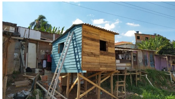
(d) TECHO unit before painting
