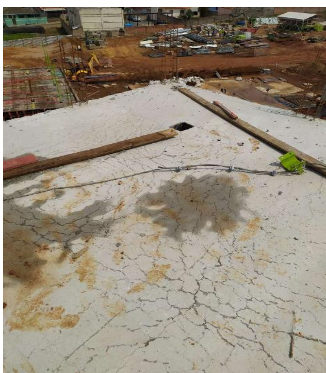
Manifestação patológica de fissuras na laje.
