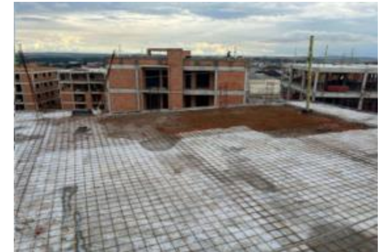
Posicionamento da armadura de reforço
