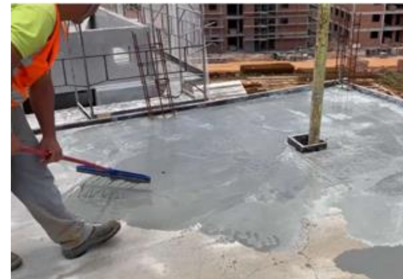
Colmatação com argamassa especial.
