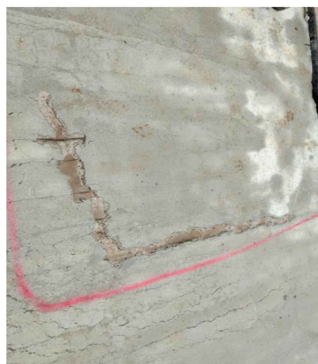
Manifestação patológica de fissuras na laje.
