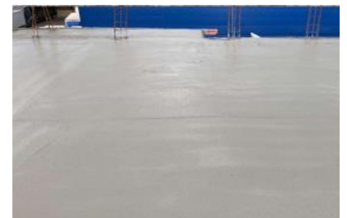
Concretagem do contrapiso
