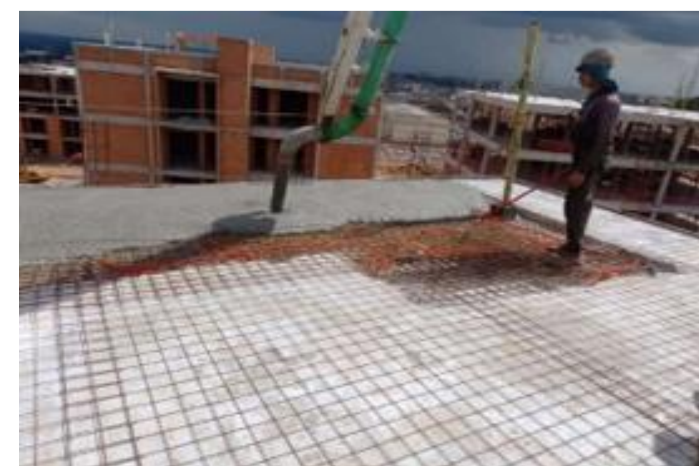
Concretagem do contrapiso
