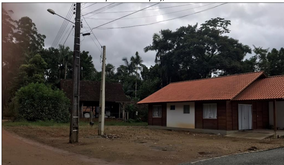
Figura 14: Visão da Casa Arno Klitzke (patrimônios: bem edificado, uso residencial e pedido de intervenção: construção), na zona rural.
