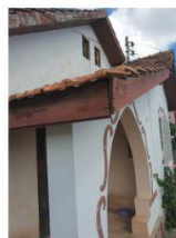
Foto 6: Vista detalhe telhado. Fonte: acervo da pesquisa, 2021.
