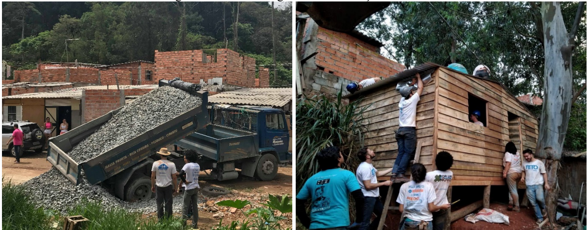
Figuras 2 e 3 – Pré-logística e Construção massiva.
