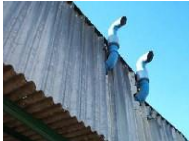
Figura 3: Exemplo de Equipamento de Proteção Coletiva
