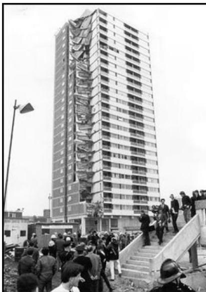
Figura 1 – Edifício Ronan Point após o colapso
