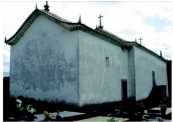
Fig. 3 – Fachada posterior e lateral direita.
