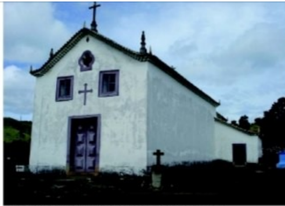
Fig. 2 – Fachada principal, lateral esquerda e ao fundo o cemitério.
