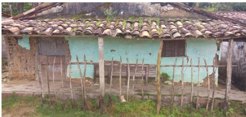
Figura 2 – Casa cedida por morador para funcionamento da sala de aula EJA
