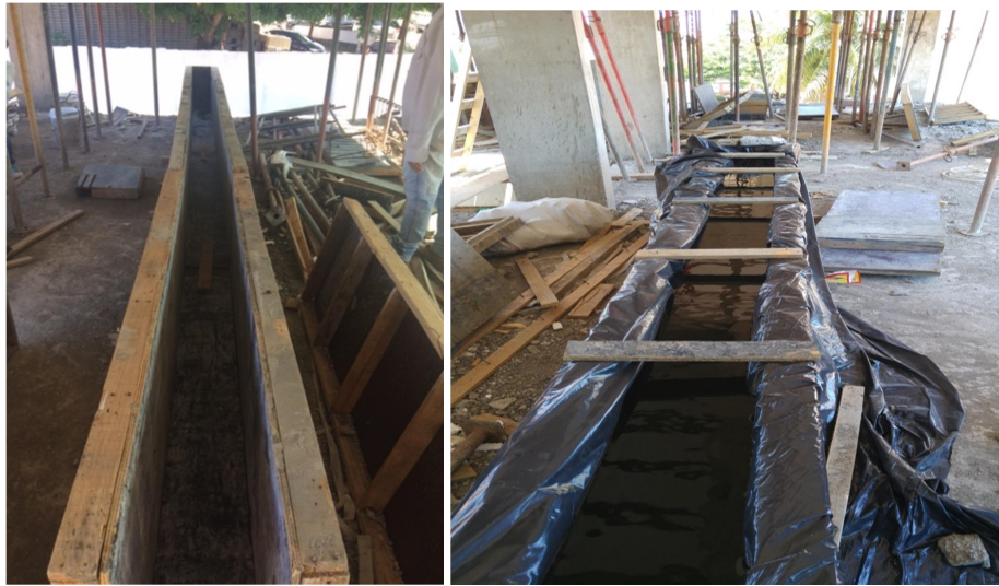
Figura 07 – Forma montada para recebimento da carga de água
