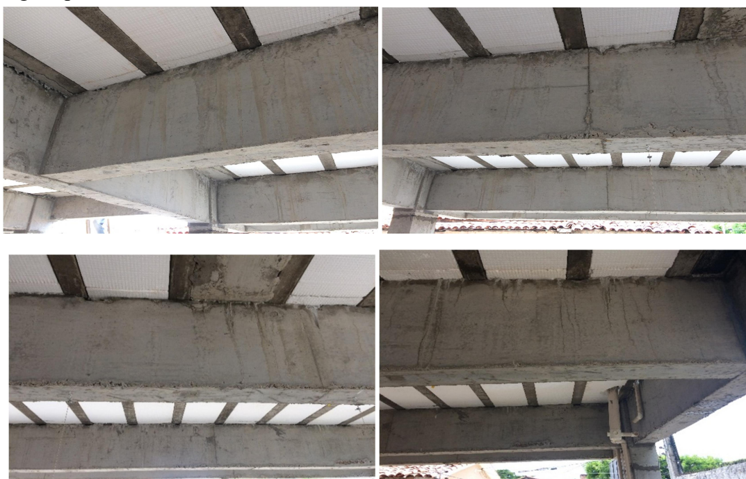
Figura 08 – Imagens da viga V3
